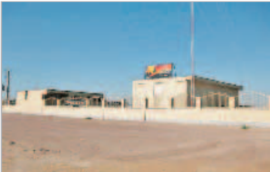
احداث مرکز آتش نشانی
