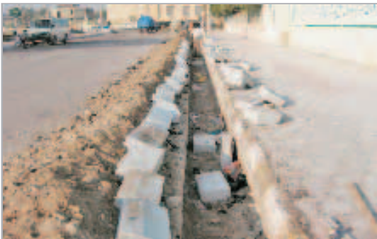
اجرای کانال و دفع آبهای سطحی
